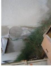
Traces d'humidité et enduit extérieur dégradé
