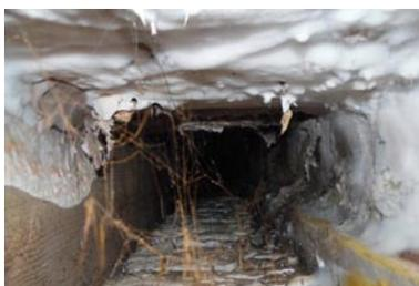
Image d'un cas extrême d'infestation par la mэрule entre les poutres d'un plancher en bois. Mais dans la plupart des cas, la contamination est moins avancée. *Ouest-France*.
