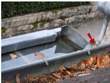
Deuxième gouttière: l'eau ne s'écoule plus.
